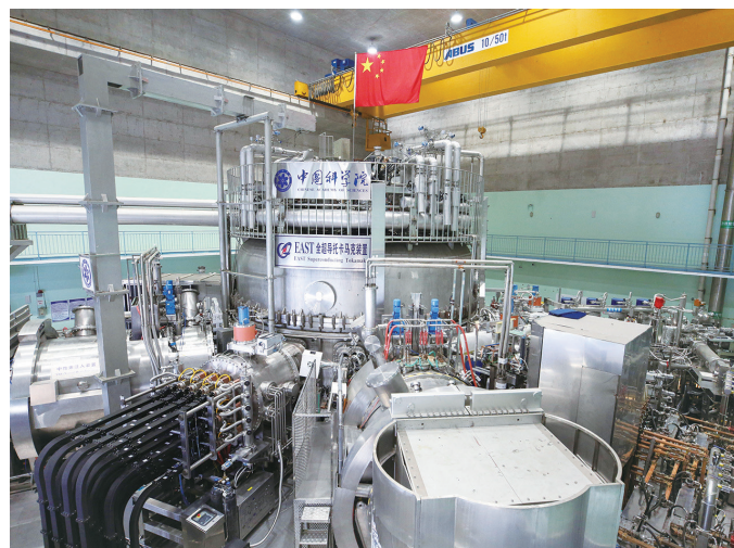
全超导托卡马克核聚变实验装置(EAST)俗称“人造太阳”。 图源新华社
