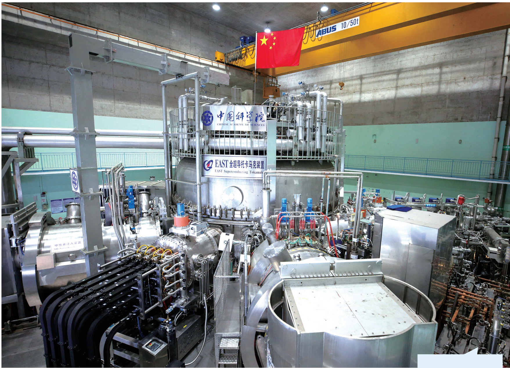
全超导托卡马克核聚变实验装置(EAST)俗称“人造太阳” 图源新华社
