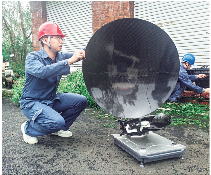
广东电力通信科技有限公司抢修队人员正在部署卫星通信设备
