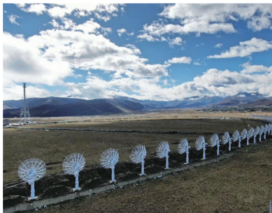
建设中的子午工程二期圆环阵太阳射电成像望远镜。
