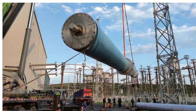
首支国产±800千伏柔直穿墙套管安装现场。
